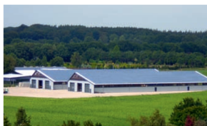
Dachflächenanlage in Schafstedt, 349 kWp
