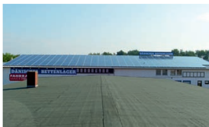
Dachflächenanlage Bettenlager, 153 kWp
