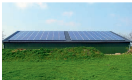
Dachflächenanlage Lagerhalle Jerrishoe, 46 kWp
